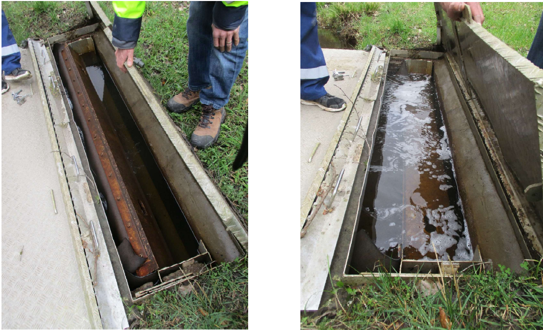
Figure 13 : Vue des batardeaux de l'ouvrage de prise d'eau (mars 2018)
